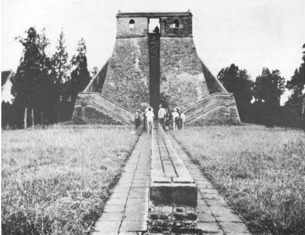
»Himmelsbeobachtungsstation« von Gao chen zhen (1279 n.Chr.). Wasserrinnen dienen zur Kontrolle der horizontalen Lage der Grad- einteilung. (Photo: Robin Rector Krupp. Mit seiner Erlaubnis)
